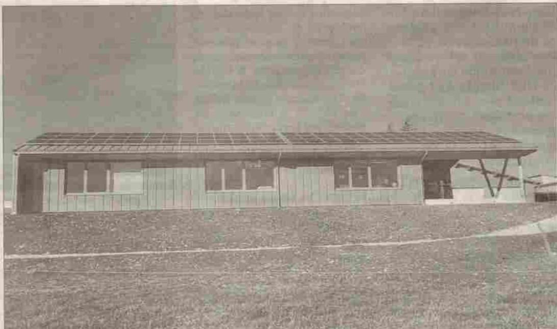
La centrale photovoltaïque installée sur la toiture de l'école de Chay. Photo ER
