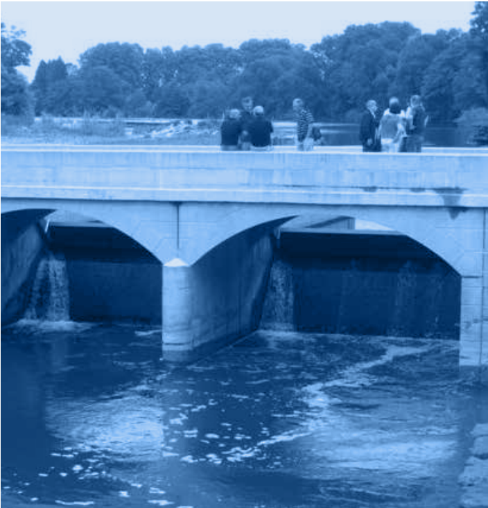
Sortie des turbines hydrauliques ©Adera
